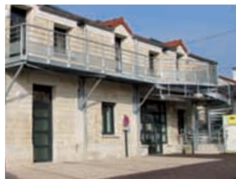
Maison de Santé pluridisciplinaire 16 ter, avenue de la république
