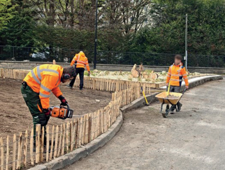
Les équipes en intervention sur la voirie.
